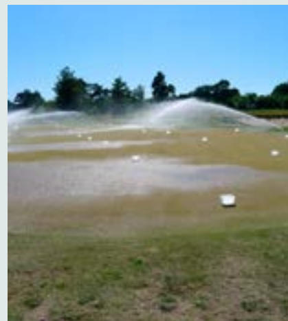
Foto 2: Intensiteten i moderne vandingsanlæg er næsten altid større end greenens infiltrationskapacitet. Derfor er regelmæssig vanding ikke det samme som jævn fordeling af vandet. Foto fra Visby Golfklub på Gotland under test af vandingsanlægget.
