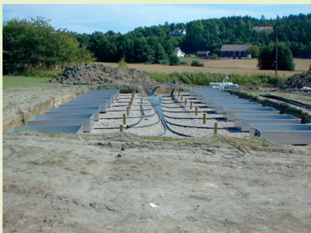
▲ Billede 1. Lysimetrene (1 m x 2 m) til opsamling af drænvand fra sandbaserede greens.
